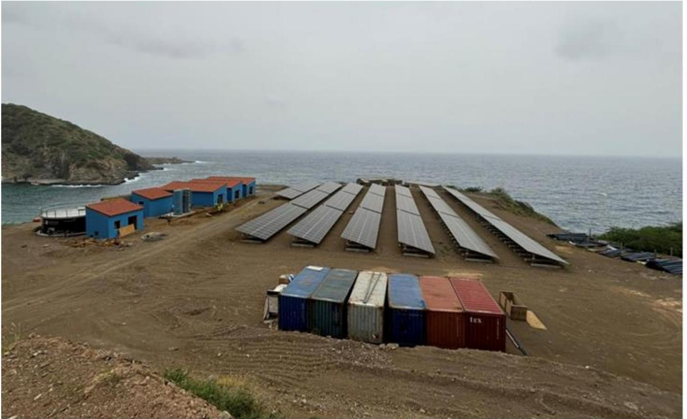
Site EDAM : édifices osmose à gauche y inclus les filtres de reminéralisation et réservoir / modules photovoltaïques à droite
